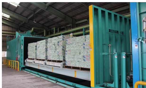
平成 29 年 6 月 21 日 真空予冷庫が稼働しました
